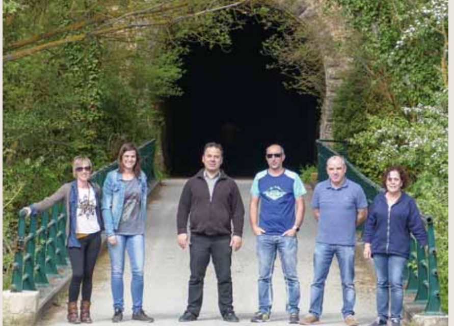
Representantes de la Asociación ante el túnel de Valdelobos, donde arranca el nuevo tramo acondicionado.
