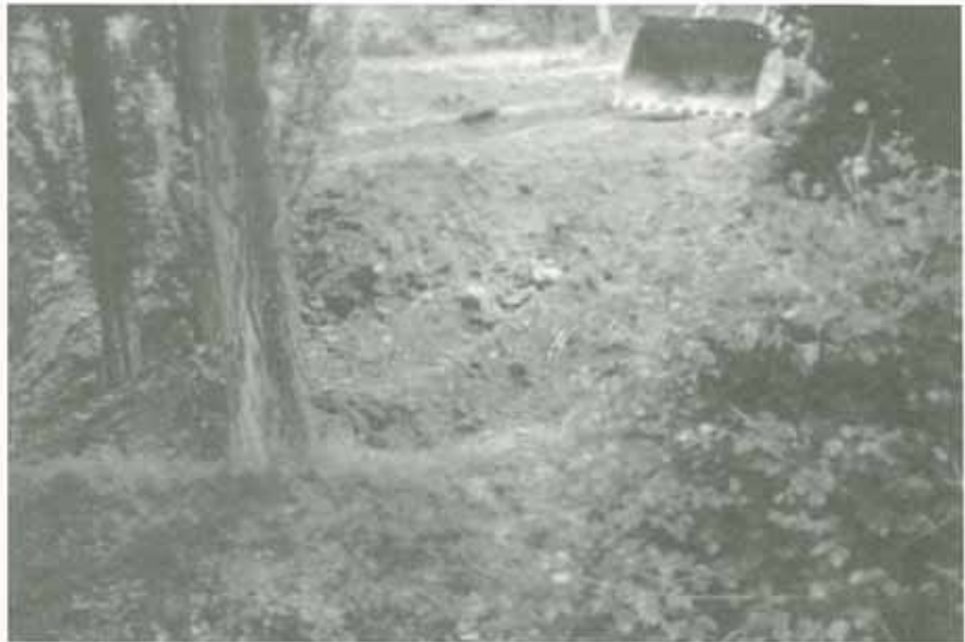
La excavadora durante los trabajos realizados.
