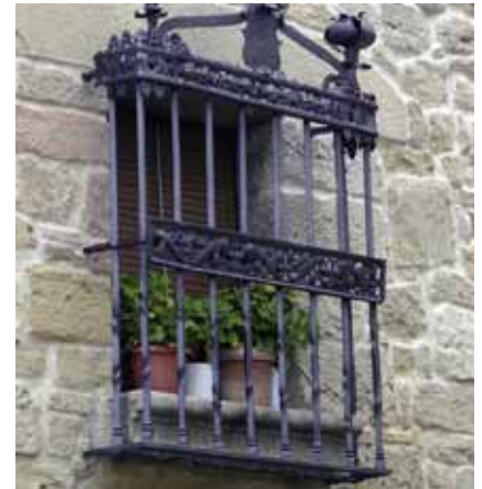
Detalle de fachada.
