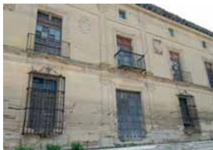
Arriba, detalle de fachada. Debajo, fachada del palacio barroco de la localidad, del siglo XVIII.
