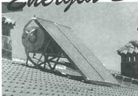
Las principales características y ventajas son las siguientes: Compactas, Económicas, Eficientes, Bajo nivel de mantenimiento, no precisan bombas o componentes auxiliares.
