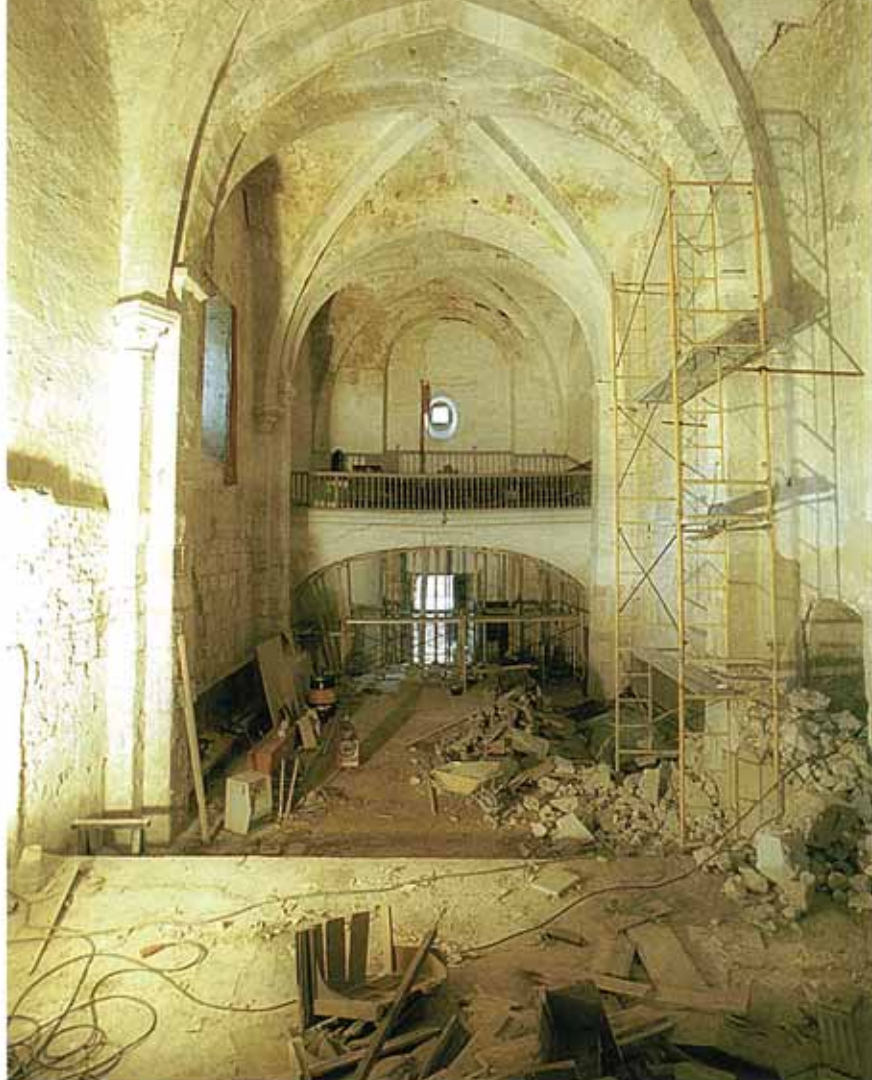
Una vista del interior del templo que no será tocado en esta fase del arreglo
