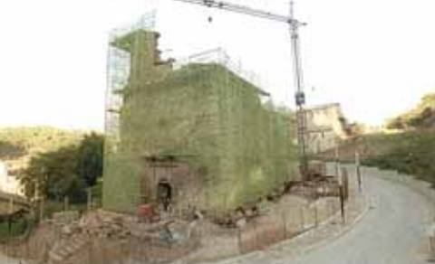
El exterior se encuentra totalmente cubierto de andamios
