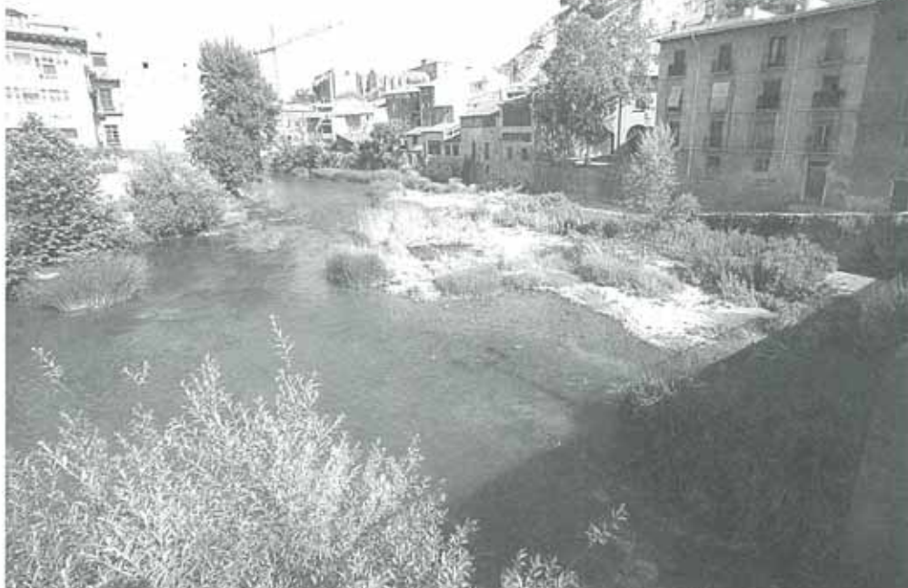
La grava acumulada en el Puente del Azucarero será retirada para permitir que la corriente circule por todo el cauce
