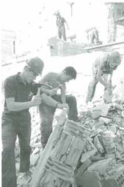
El Taller de albañilería, el primero en intervenir
