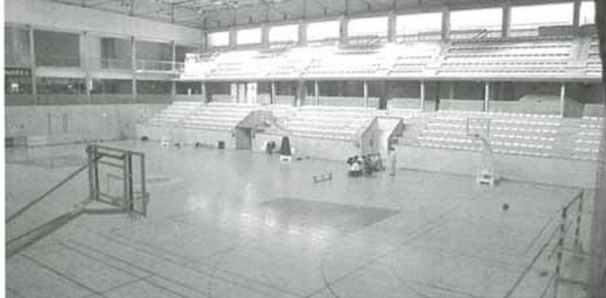
El inicio de las obras depende del secado del suelo
