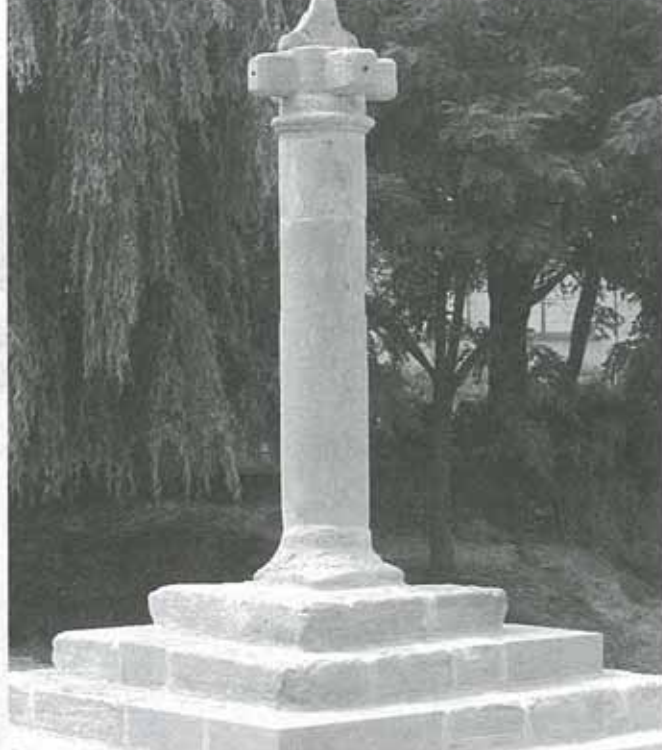
Sólo queda poner el crucero superior para terminar la obra de la picota
