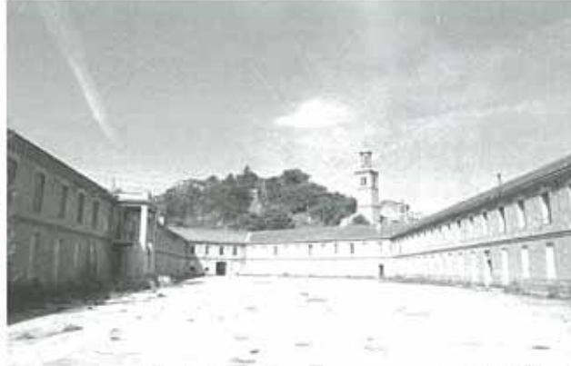
El edificio y los terrenos ocupan un solar de 18.000 m 2
