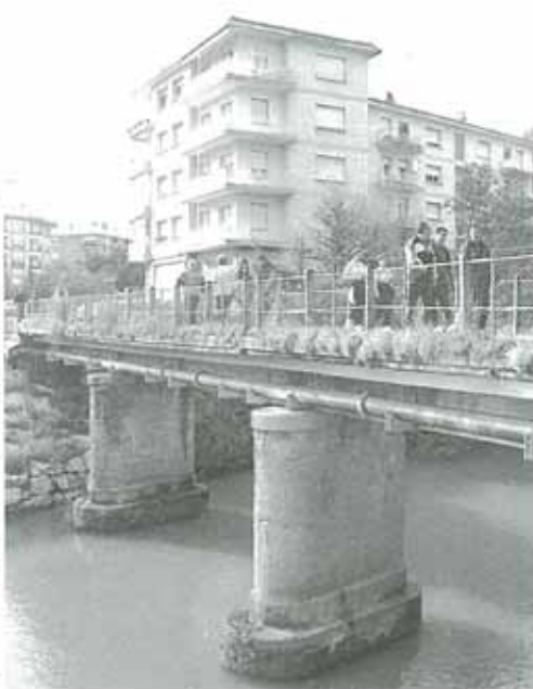
La construcción del Puente de la Vía, la inversión más fuerte con 140 millones
