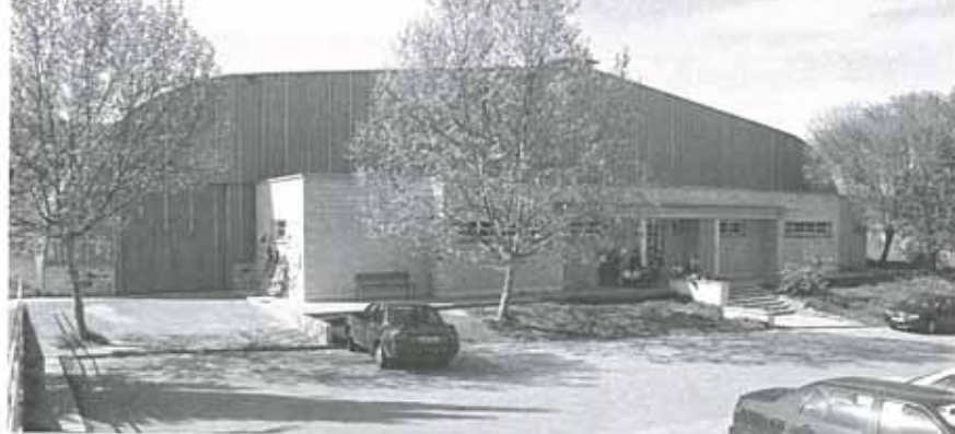
Las obras de la carpa Oncineta comenzarán a finales de mayo
