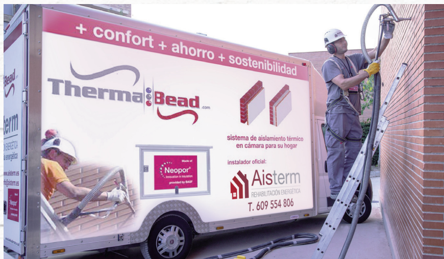
Aisterm dispone de unidades móviles 'ThermaBead' equipados con toda la maquinaria necesaria para realizar el aislamiento.
